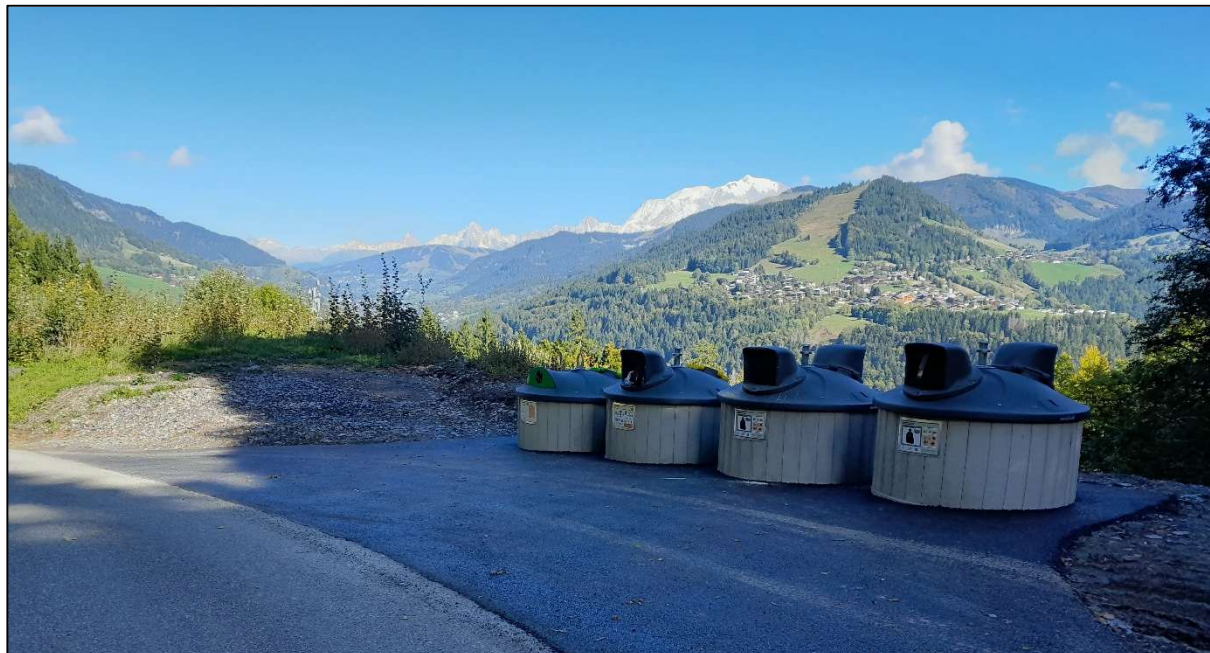
Première plateforme de CSE à Saint-Nicolas-la-Chapelle, route des Combes
