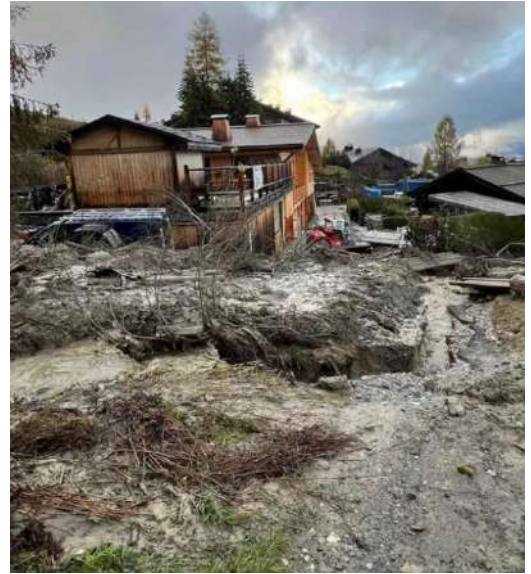
Débordement du ruisseau du Tour en novembre 2023
