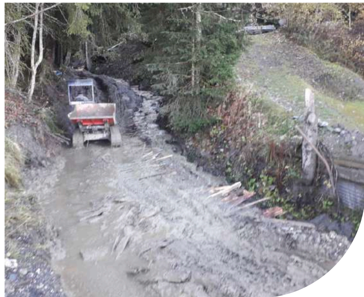
Curage du ruisseau du Tour (Megève)
