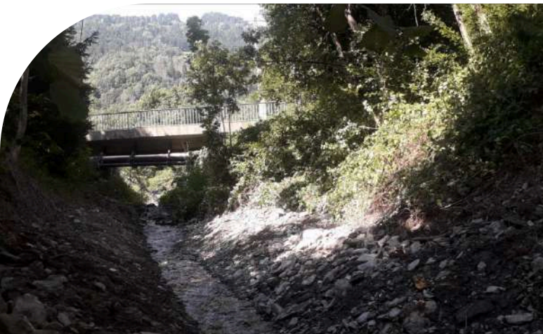
Curage du grad Nant de Villard (Villard-sur-Doron)
