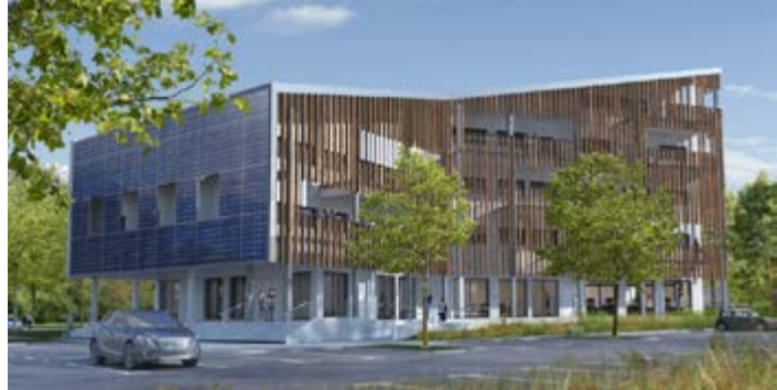
Bâtiment d'activités tertiaires « La Canopée » - ZAE de Terre Neuve
