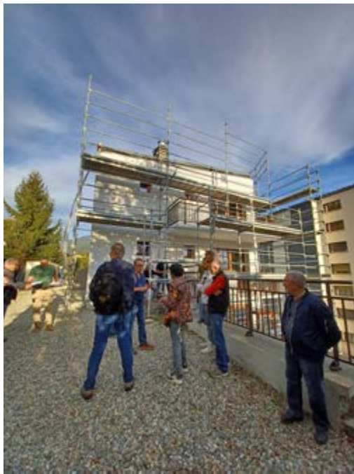
Visite de travaux énergétiques réalisés dans une copropriété ©Arlysère
