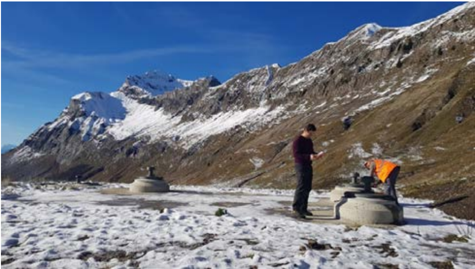
Ugine - Travaux de captage d'eau - Merdassier du Levant ©Région AURA
